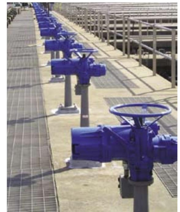
MX执行装置一直使用合成齿轮机油，特别适用于涡轮转动装置。它是第一台使用钢制蜗杆的非浸入式执行装置，电动控制设计并使用表面安装技术进行生产。作为真正被全球公认的设备，MX符合所有相关的欧洲指令，包括：防爆指令 (ATEX)，电磁兼容指令 (EMC)，机械和噪声指令，并带有与这些规范相关的CE标志。
